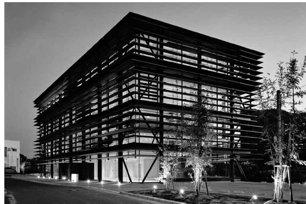
建物は全面ガラス張りで、四方を木製の庇が取り囲んでいるデザインが特徴的だ
