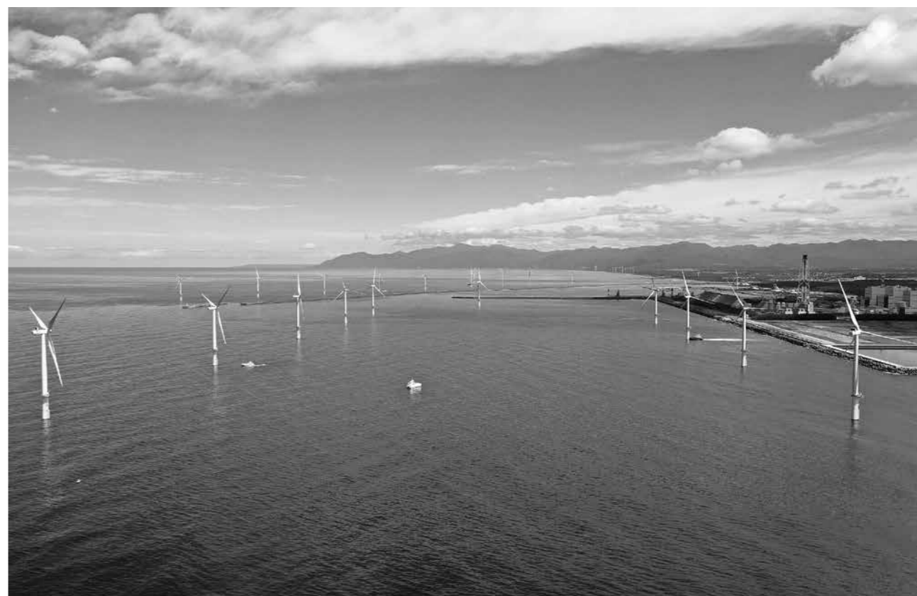
2022年12月22日に商業運転を開始した能代港洋上風力発電所
