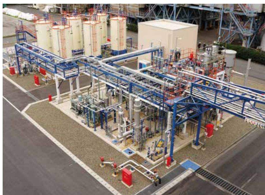
川崎側 脱水素プラント
